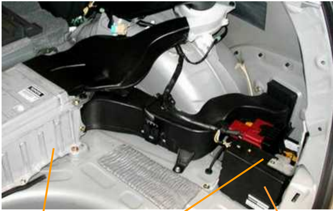
201,6V Hochleistungs- Batterie
